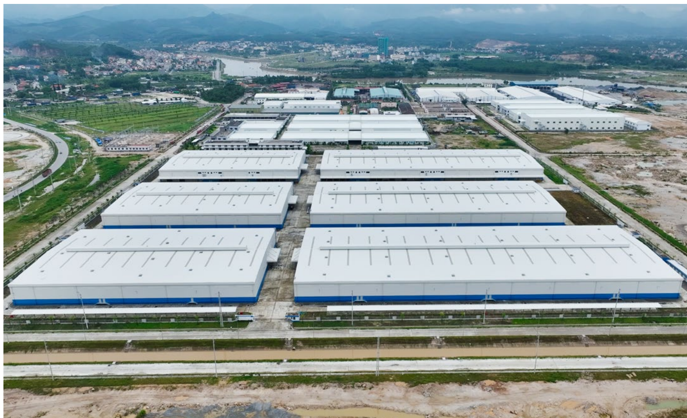
NHÀ MÁY SẢN XUẤT Ô TÔ HYUNDAI
